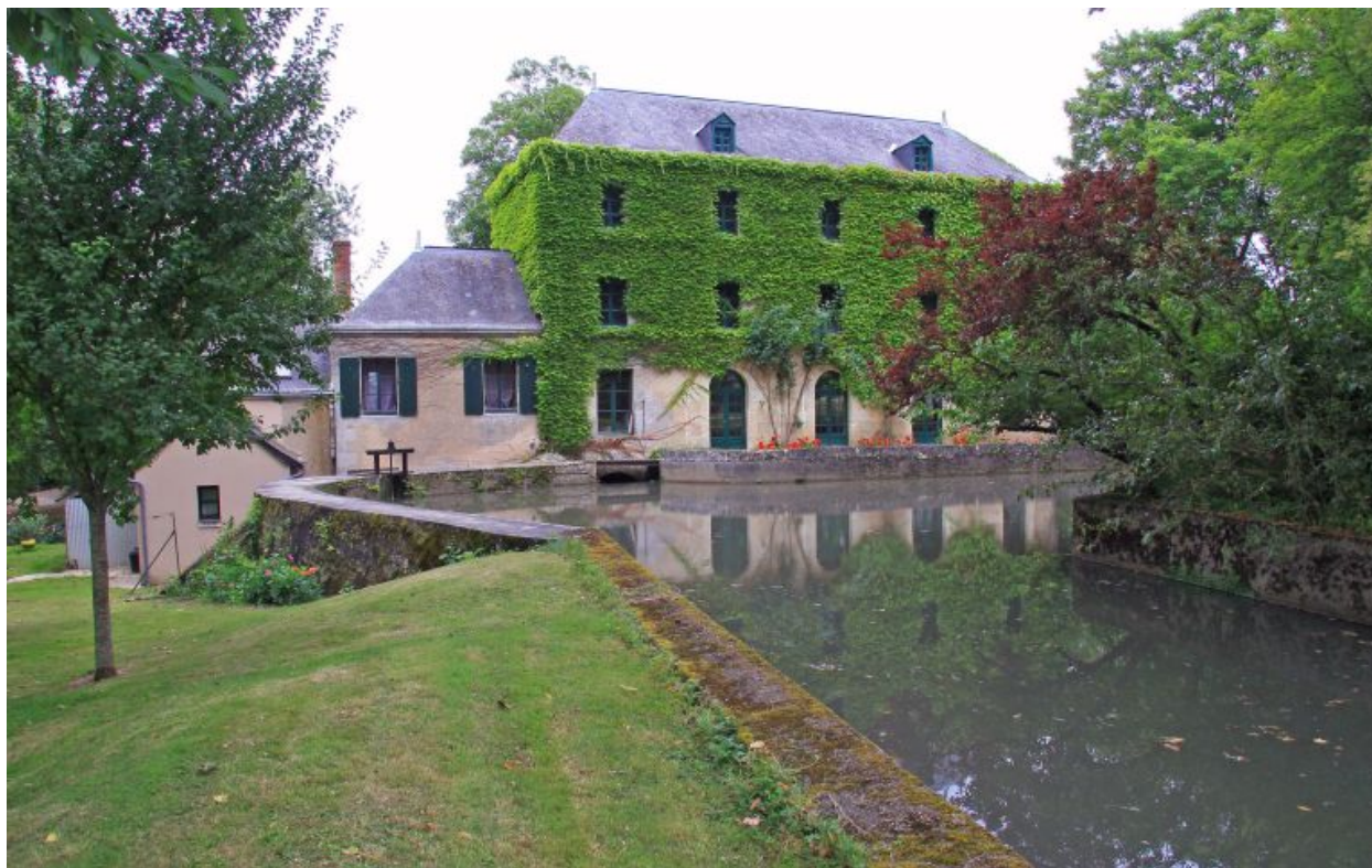
Vue d'ensemble du moulin.
