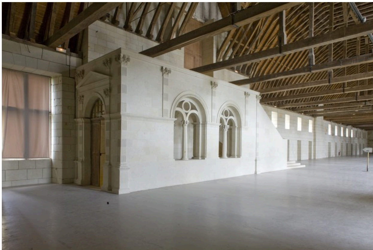
Aile est du cloître, étage-carré, dortoir des religieuses, intérieur (milieu XVI e siècle) : tambour de l'escalier monumental.
