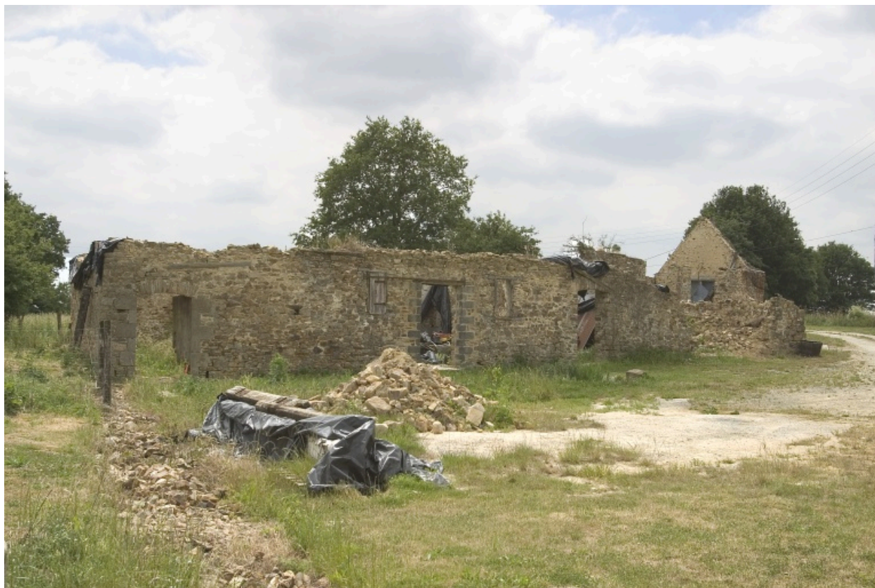
L'étable et la remise.
