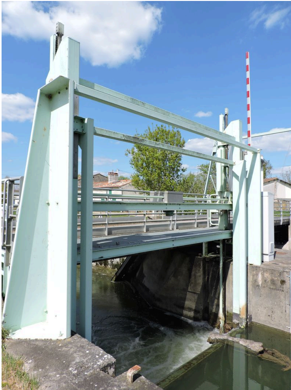
Le portique au-dessus du barrage, côté amont.
