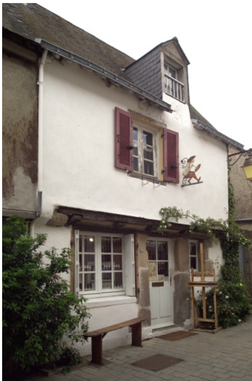
Vue de la façade sur rue.
