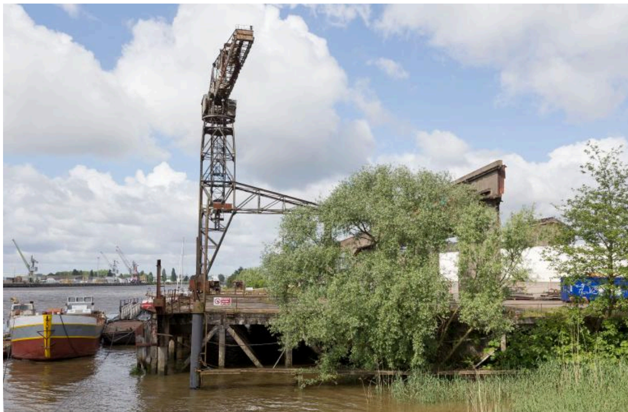
Cale et grue.
