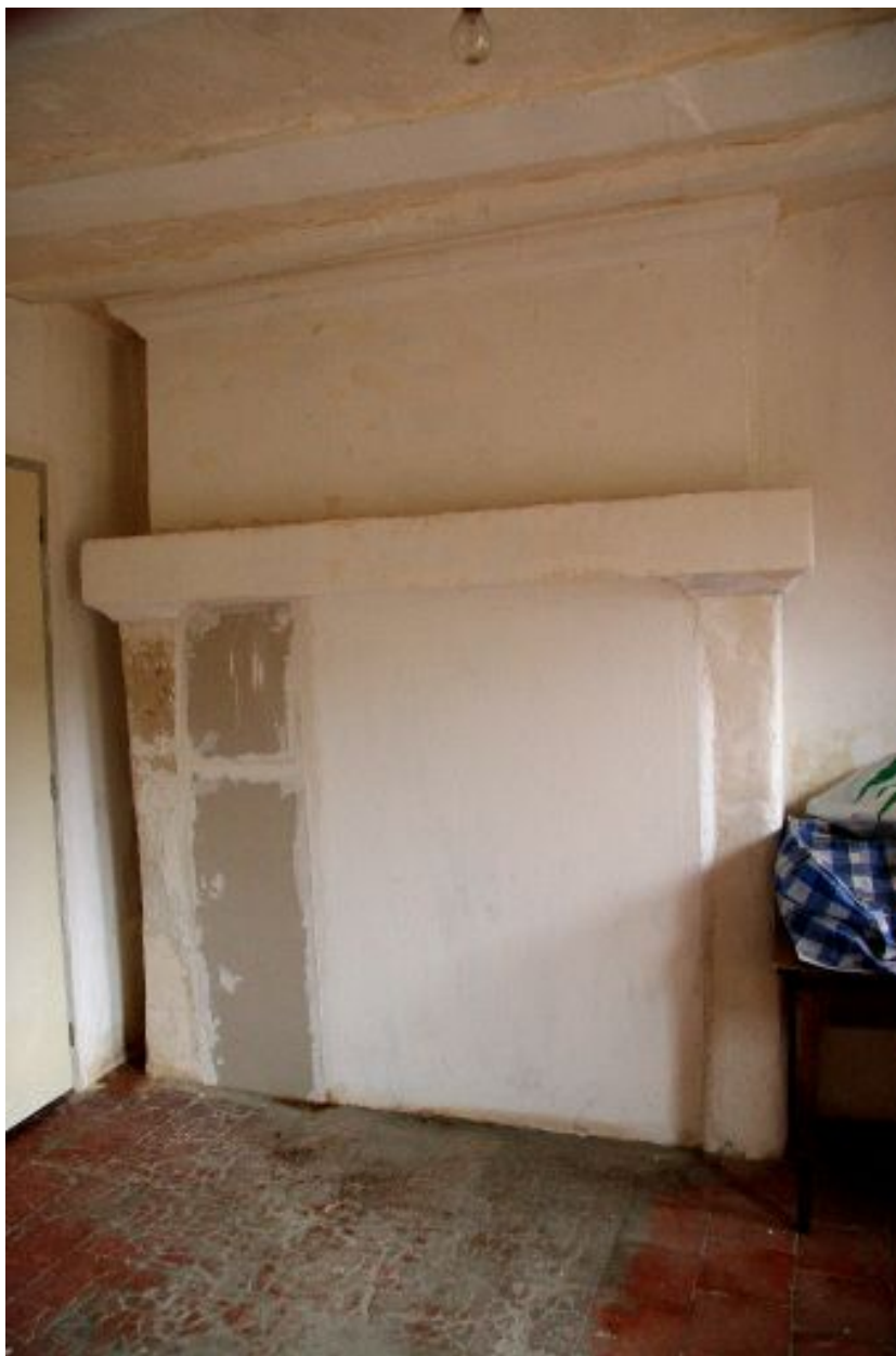
Maison de potier : cheminée salle à droite.
