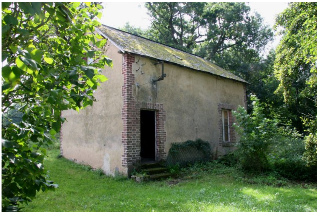
Façade antérieure prise de l'aval.
