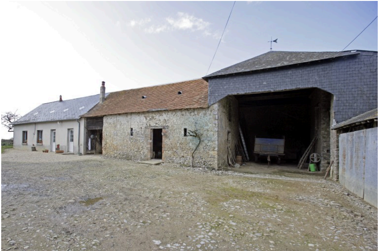
L'alignement nord vu depuis la cour au sud-est : le logis, l'étable à vaches et la remise.
