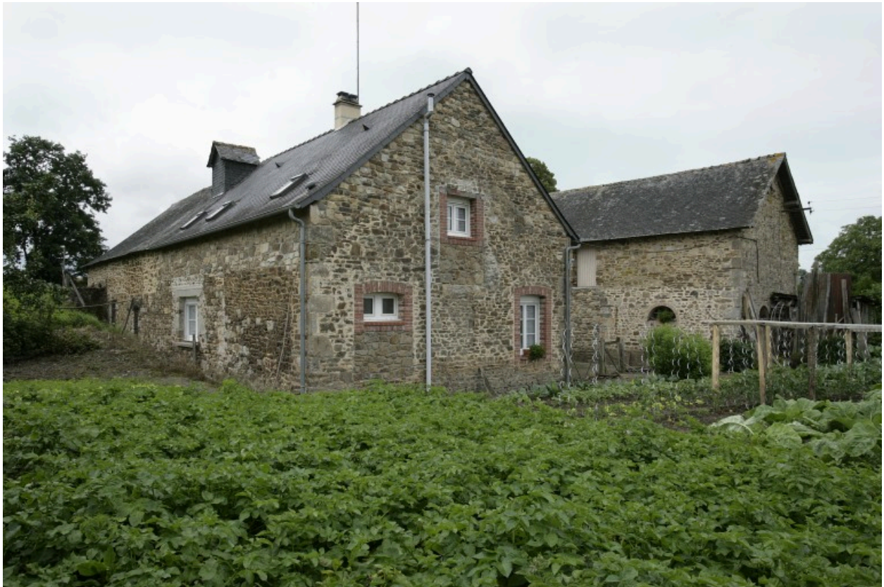
Vue d'ensemble depuis l'est : le logis-moulin et l'étable.
