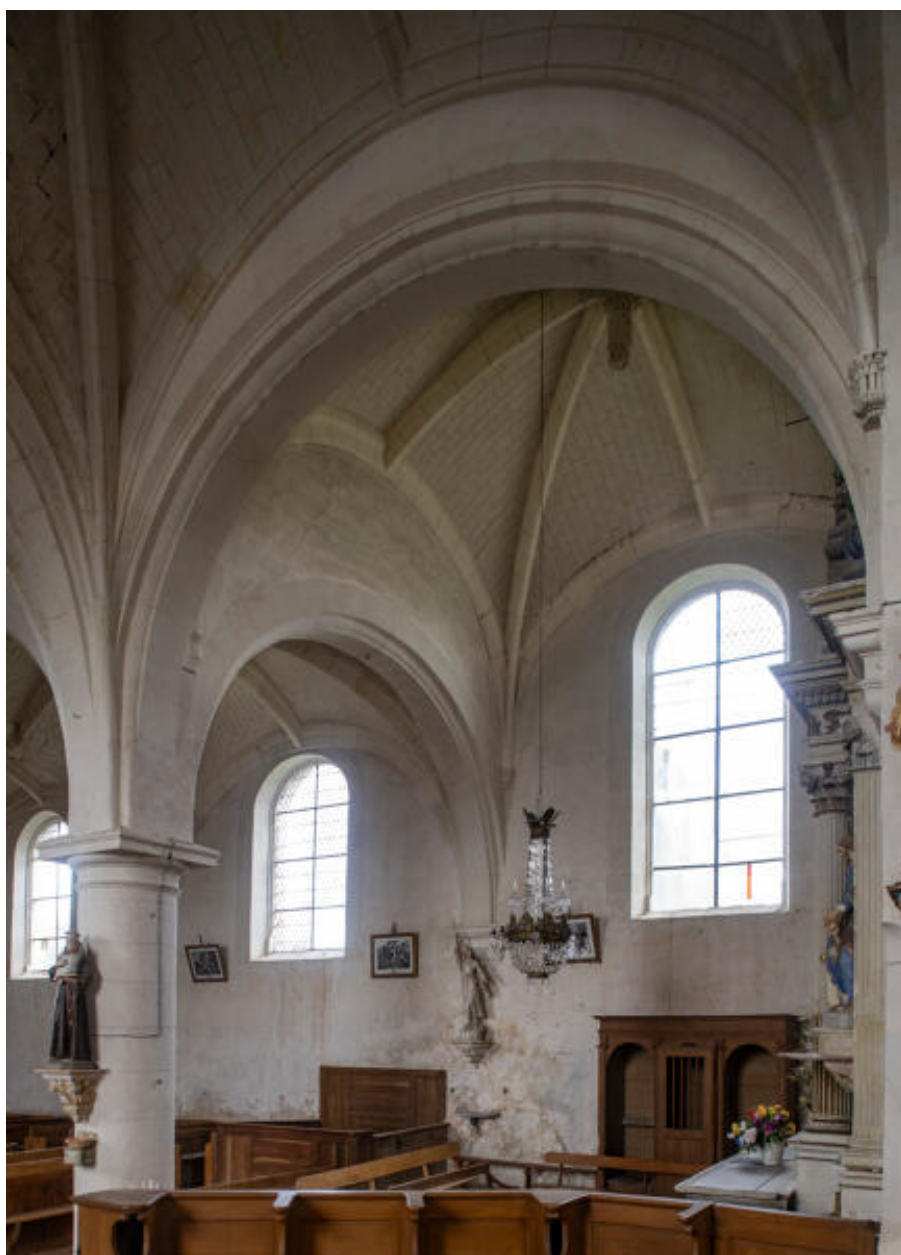
Ancienne chapelle nord, actuellement 4e travée du collatéral.
