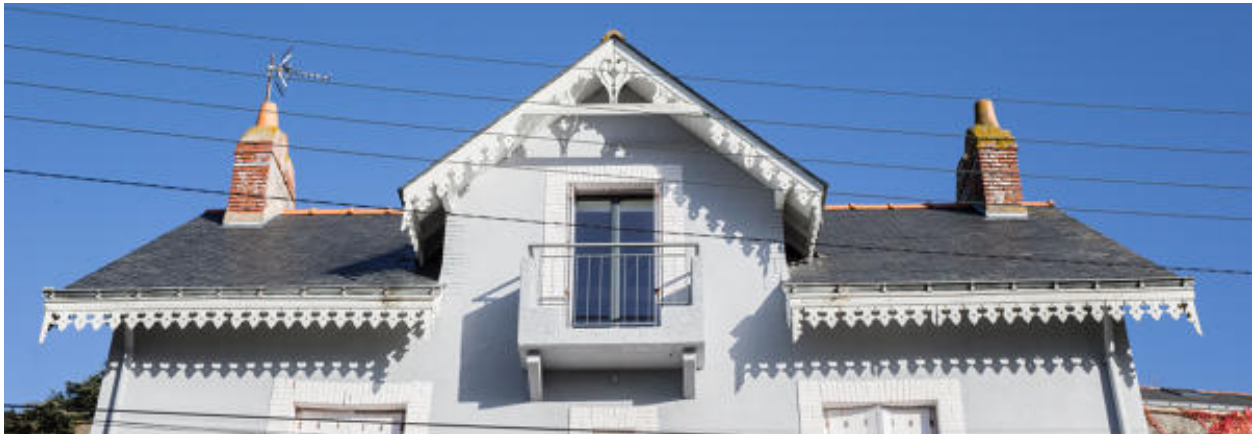
Maison, 8 quai Henri-Brunais. Détail de la lucarne et du décor de toiture.
