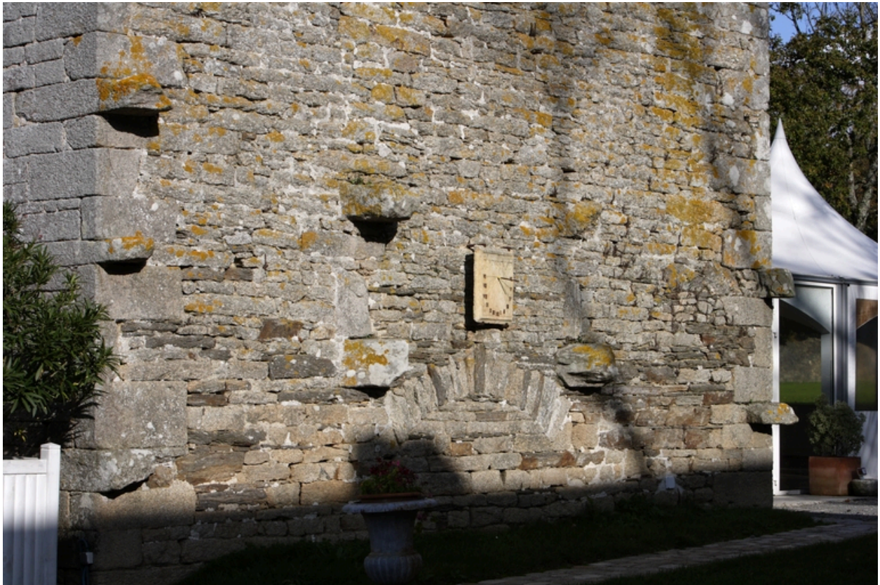
Logis. Aile est. Pignon sud. Détail des pierres d'attente sur le pignon sud.
