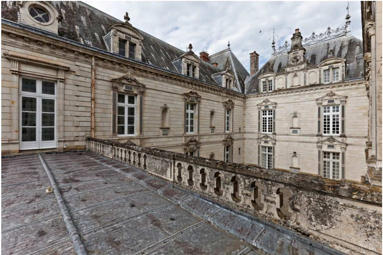
Façades sur la cour, prises au-dessus du portaique.
