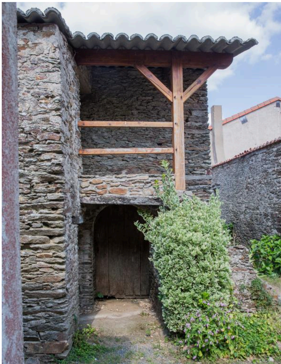
Habitation en étage carré sur cellier. Auvent remanié. Pé de Sèvre, Le Pallet. Cadastre 2018, BM 01-578
