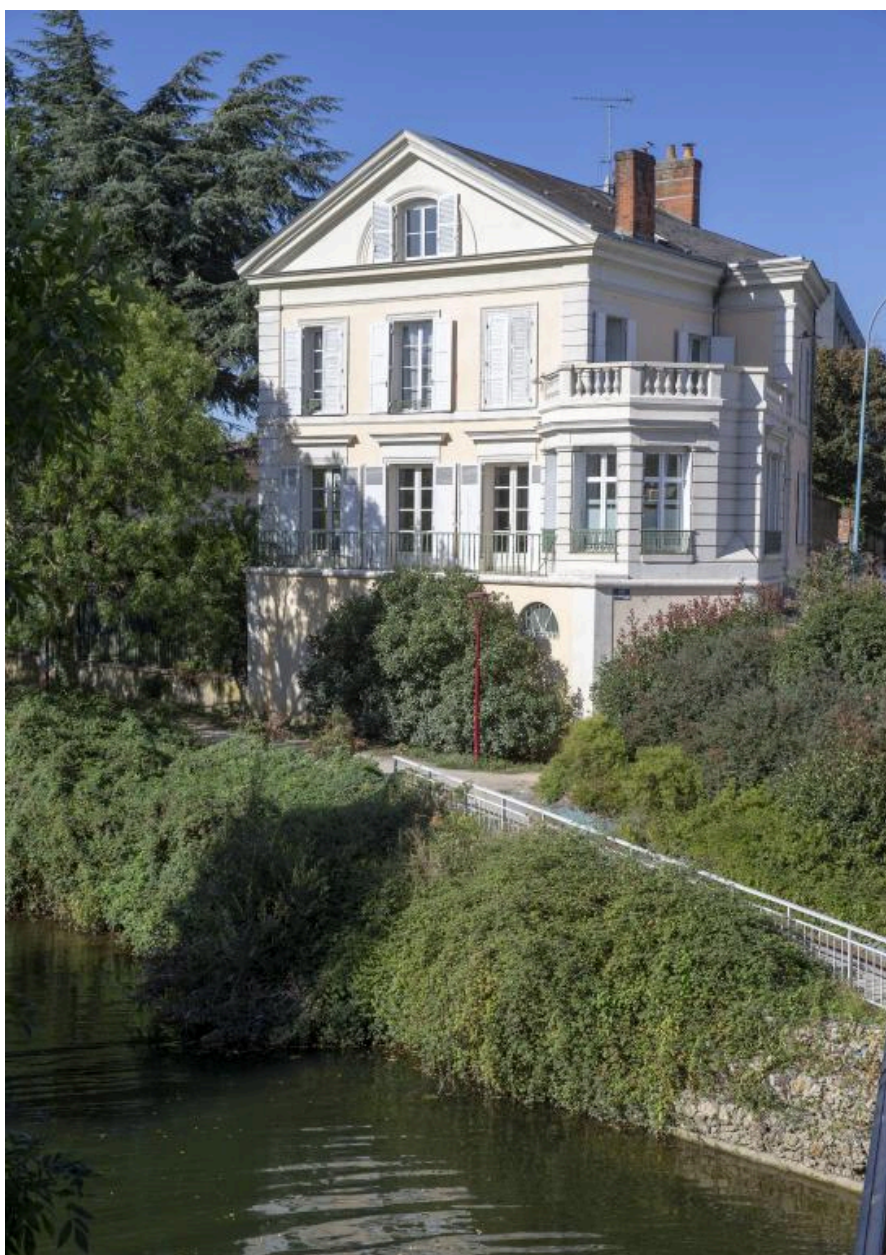
Vue de la maison depuis le pont de fer.
