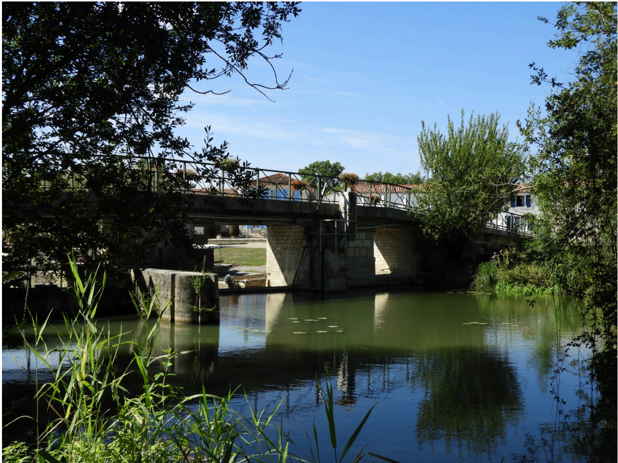
Le pont en amont du port, au débouché du canal de Bourneau, vu depuis l'amont.
