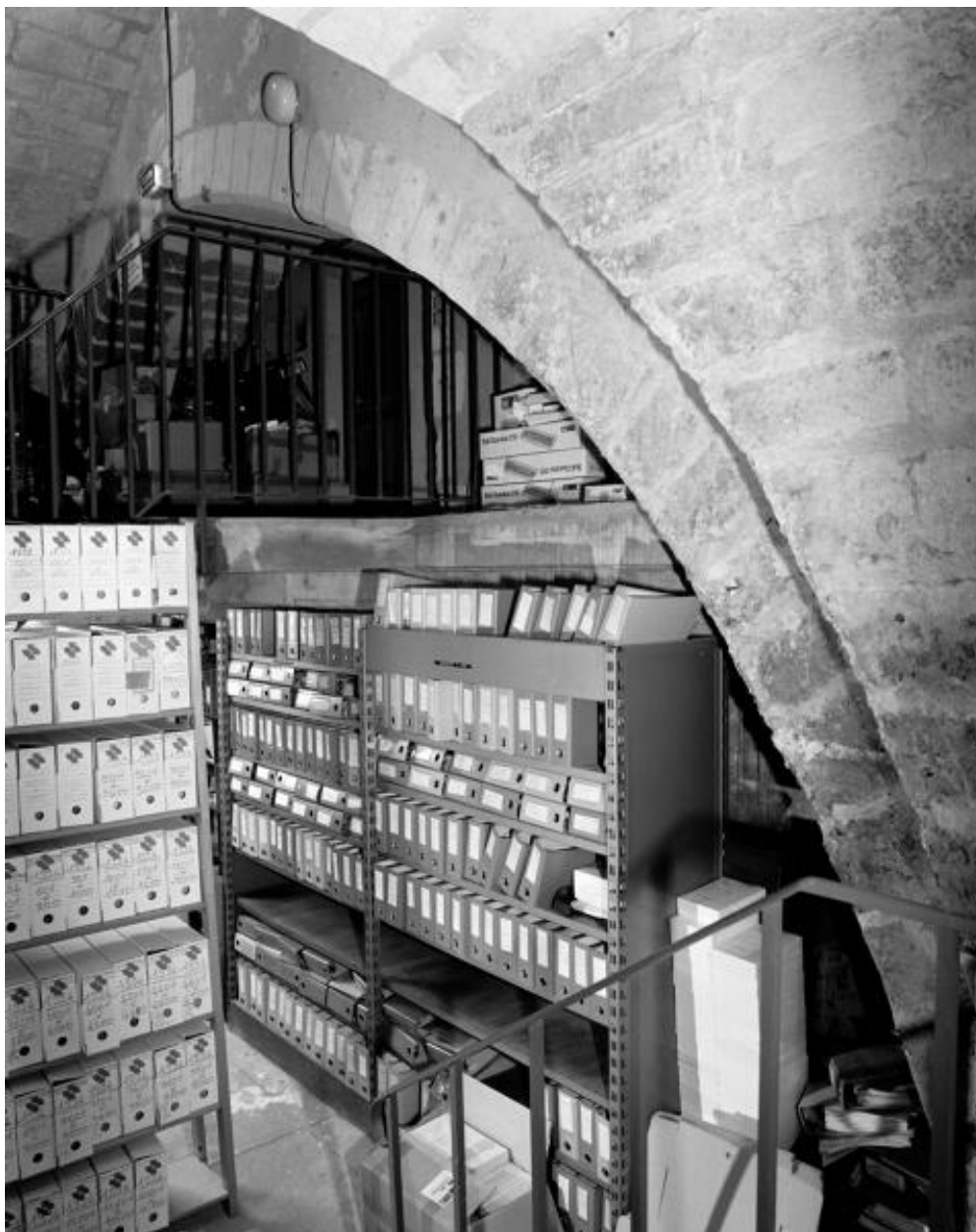
Aile occidentale de l'abbaye, premier niveau (celliers) : détail sur l'un des arcs diaphragmes.
