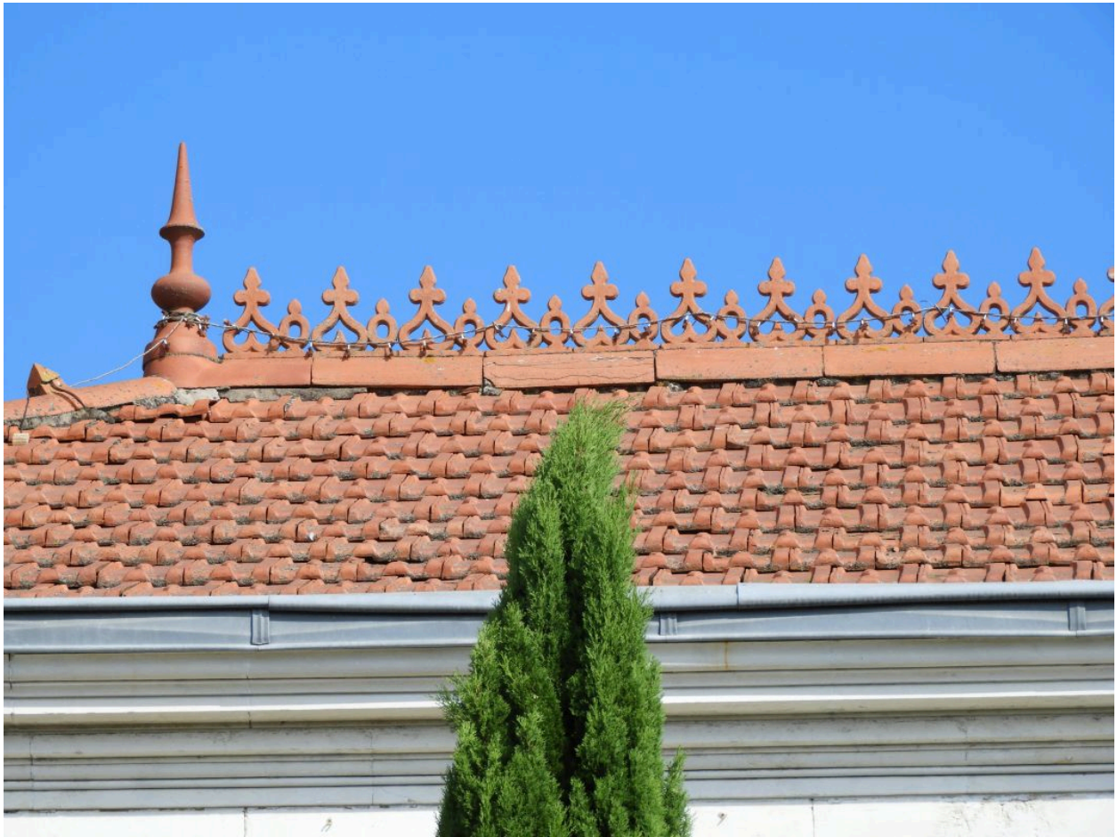
Détail du toit : épi et crêted de faîtage.
