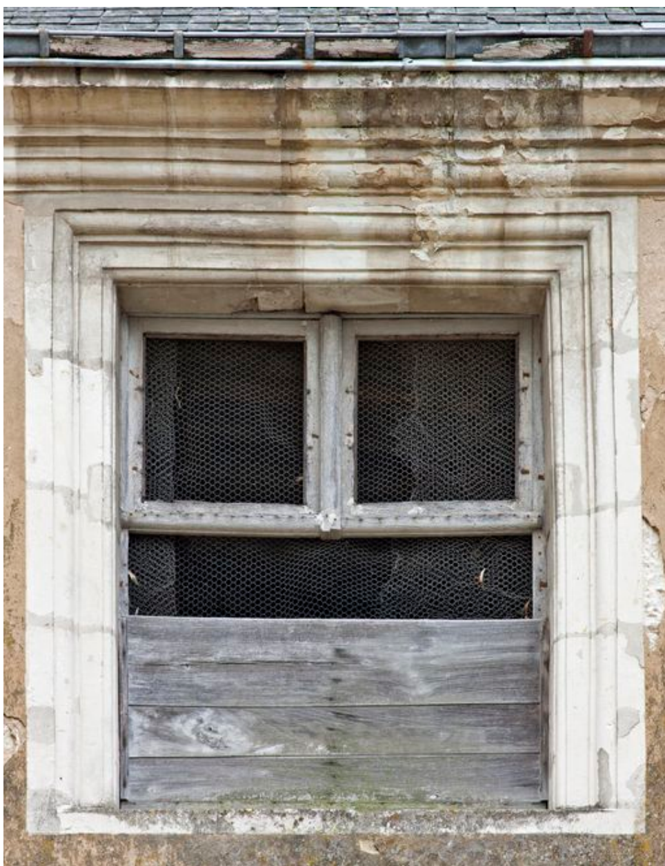
Aile en retour dans la cour, détail : baie du 1er étage.
