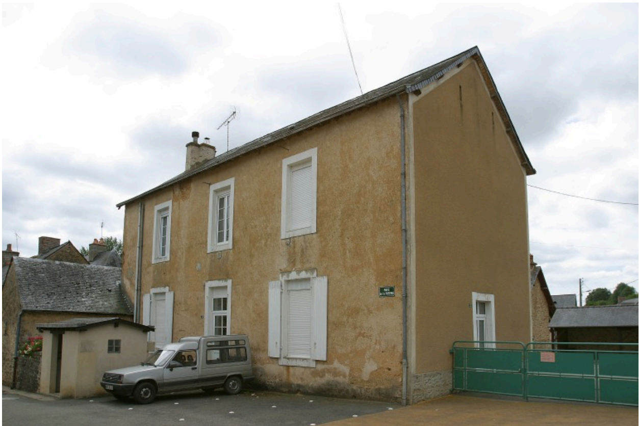
Bâtiment de logement et de classe : élévation nord sur la rue de la poterie.
