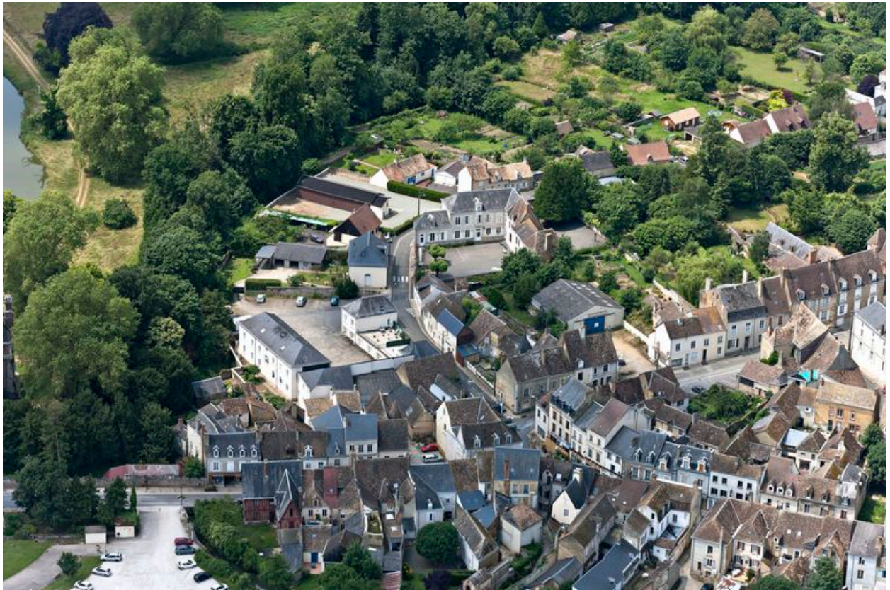
Vue aérienne depuis l'est.
