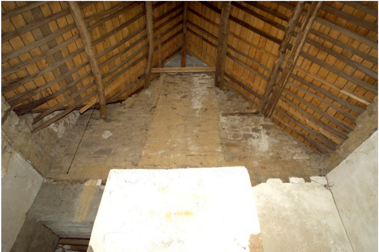
Bâtiment sud, charpente vue vers l'Est.
