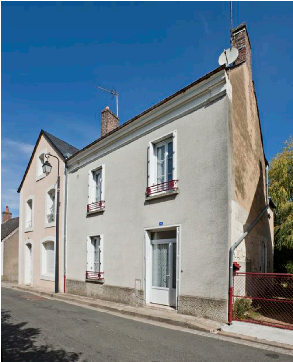
Vue générale. A gauche, l'ancienne maison de maître, puis maison de directeur
