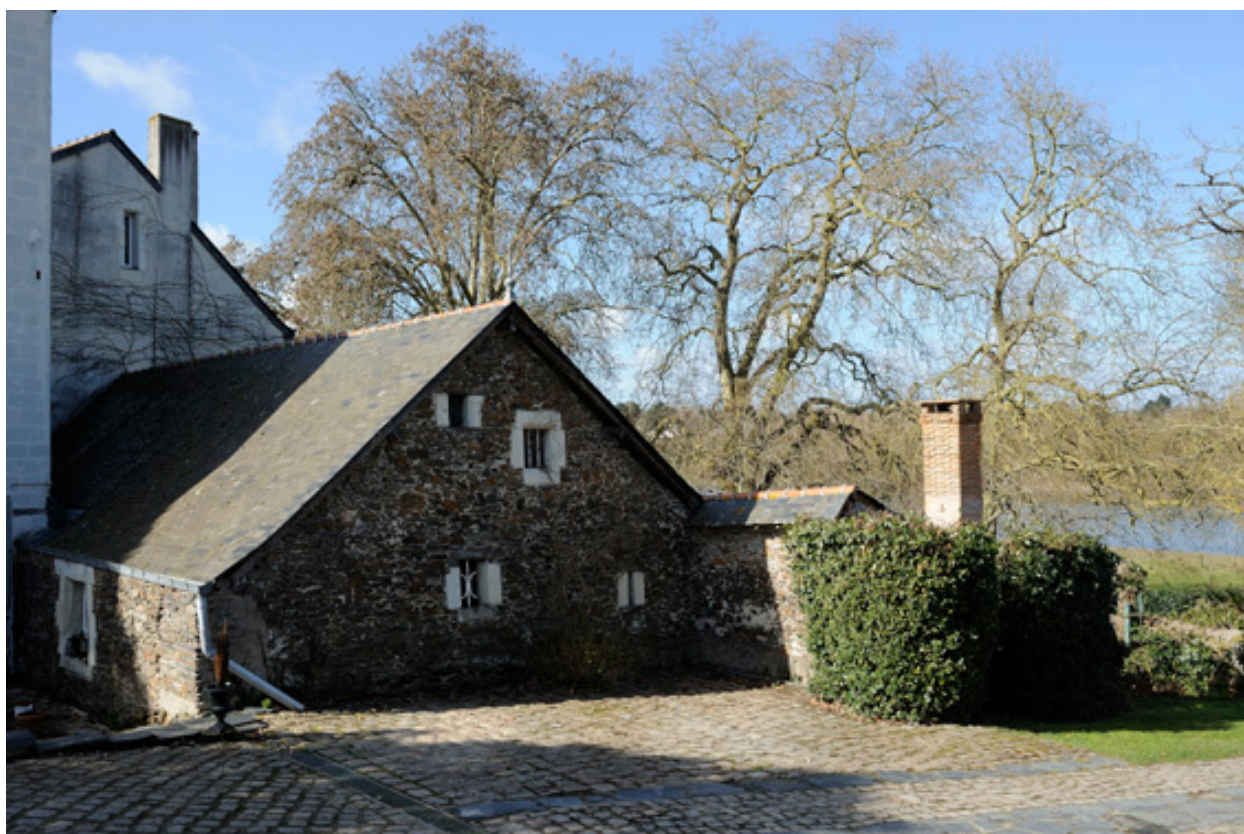
Le cellier. Vue de profil.
