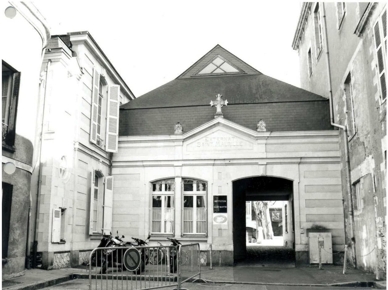
Externat Saint-Maurille : élévation antérieure de la porterie.
