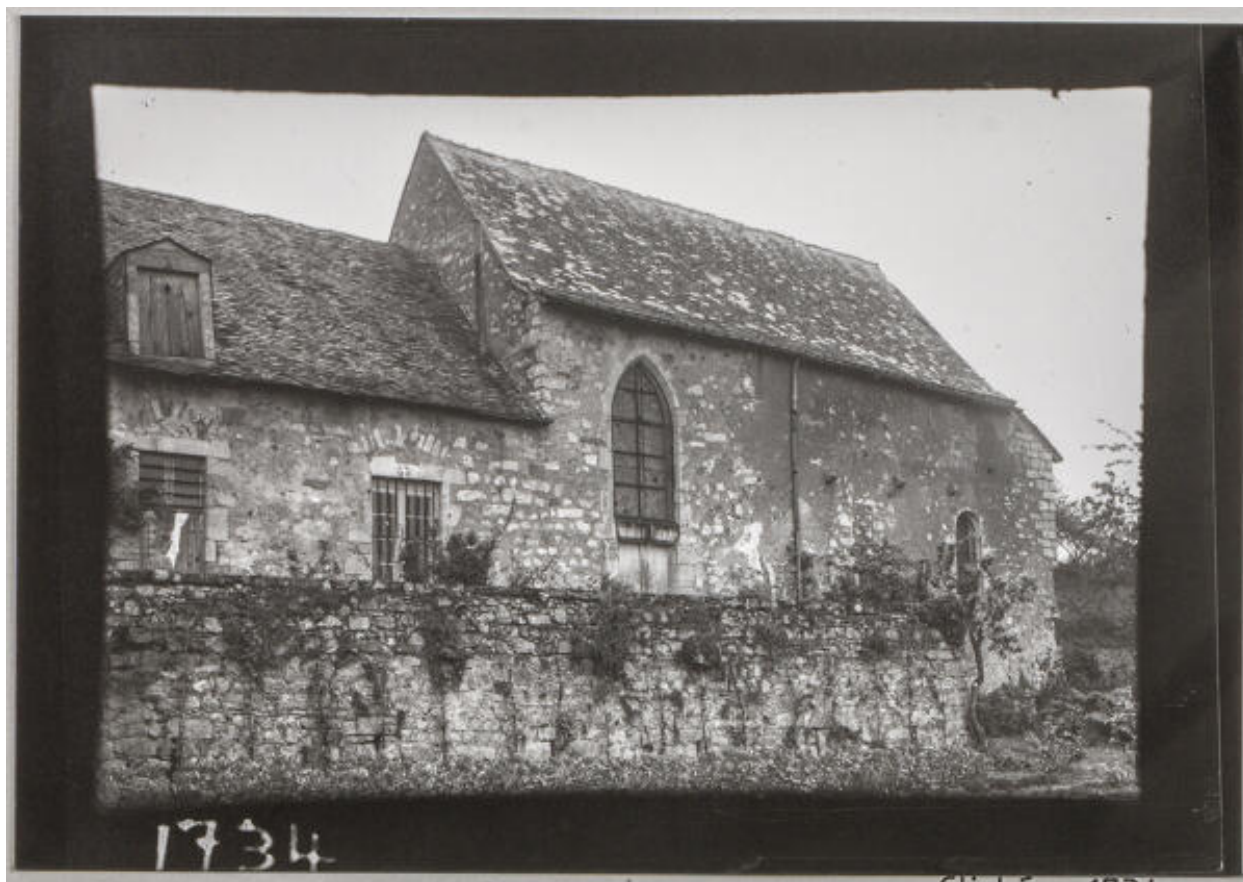
Vue du flanc sud de la chapelle Saint-Blaise et du bâtiment accolé en mai 1931.
