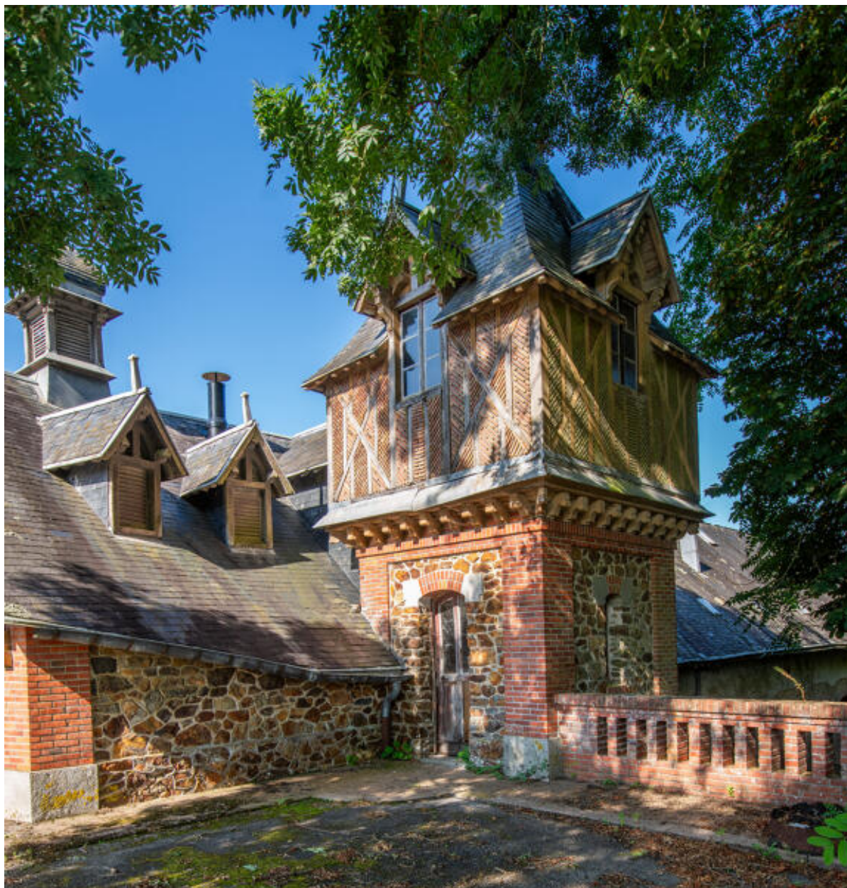
La tour château d'eau.
