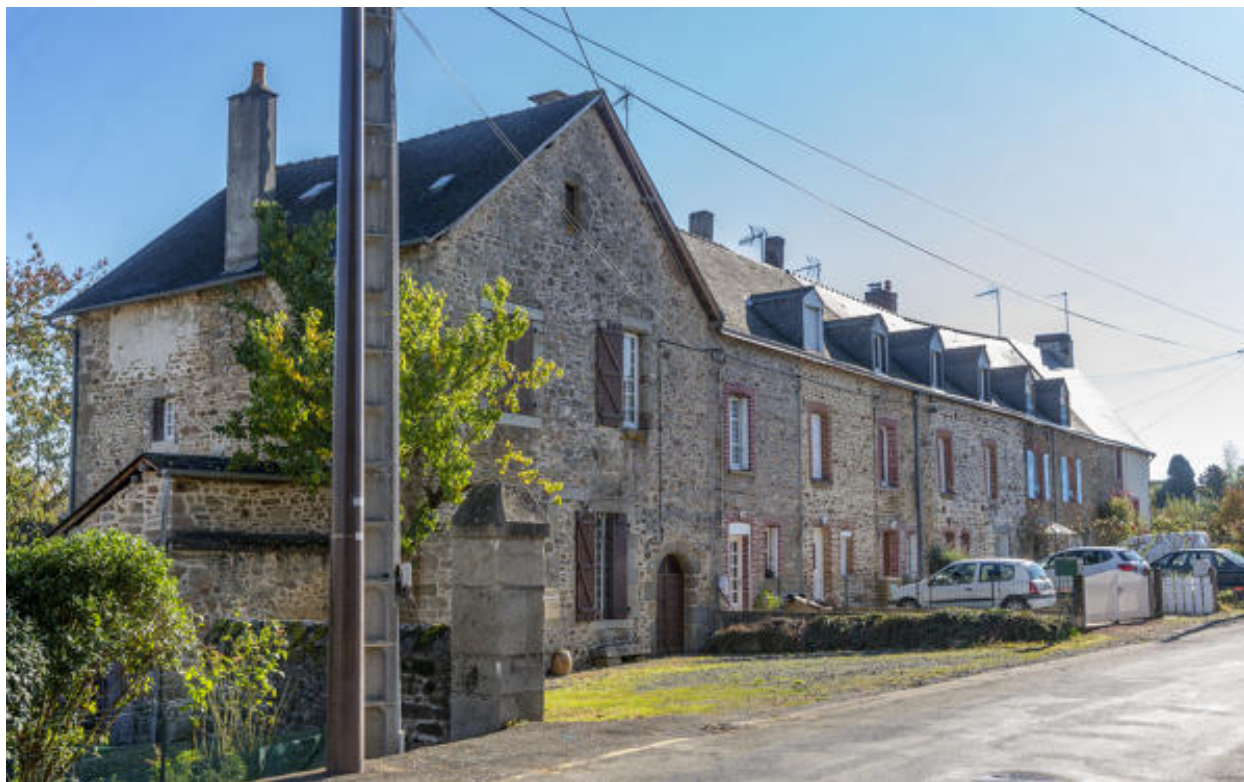
Le corps de bâtiment subsistant.
