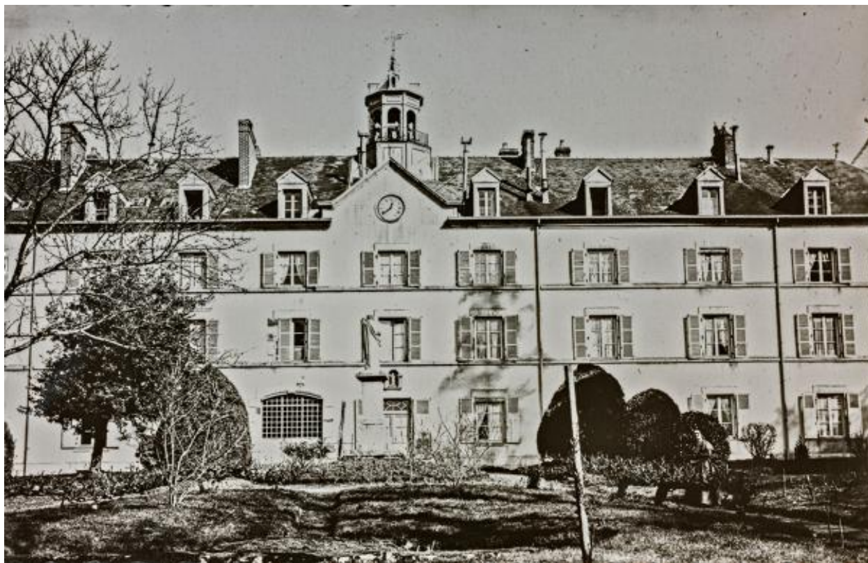
Face sud de l'actuel bâtiment C.
