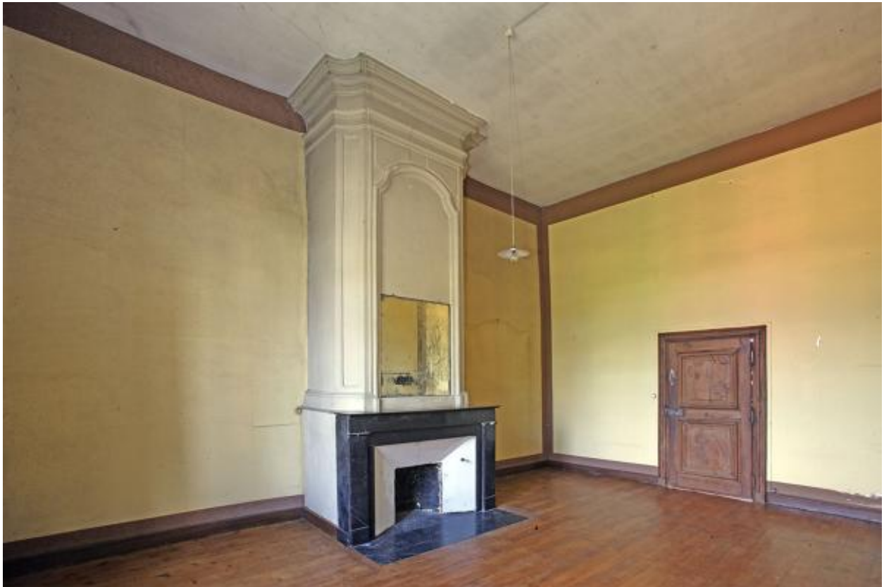
Une chambre du premier étage dans le corps central, cheminée.
