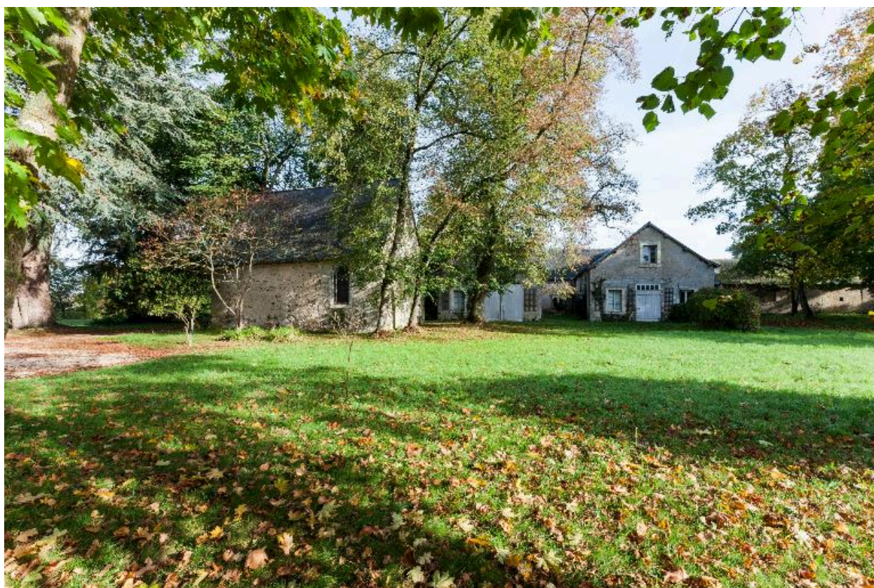
La chapelle et le bâtiment des commun vus depuis le sud-ouest.
