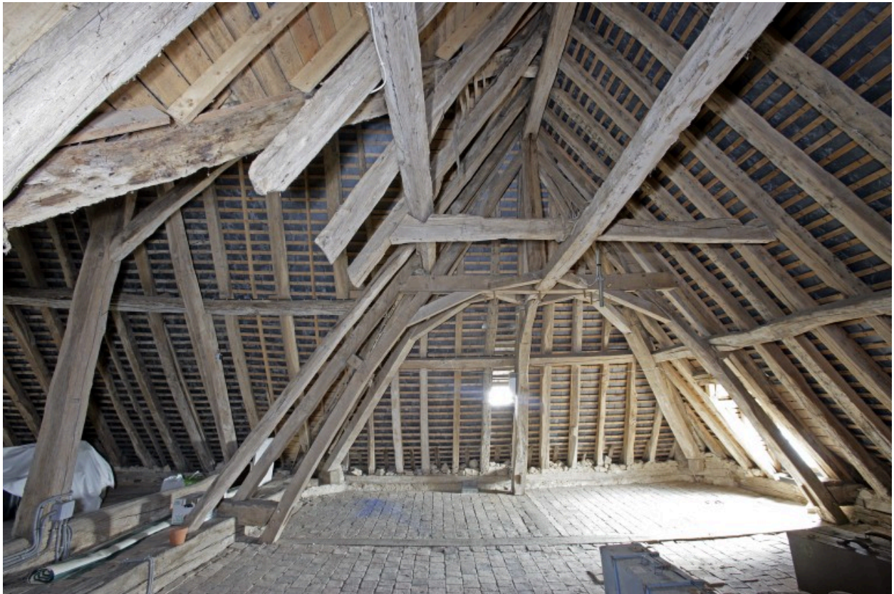
La charpente du corps principal vue depuis l'ouest.
