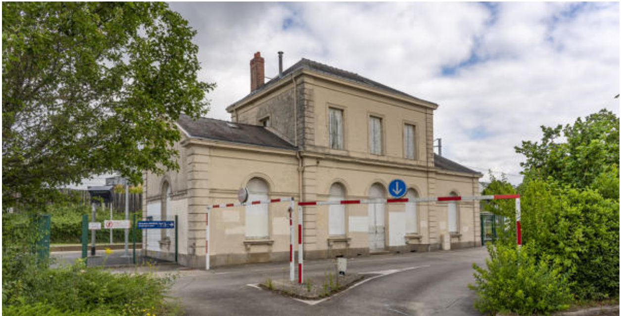
Vue générale de la façade antérieure.
