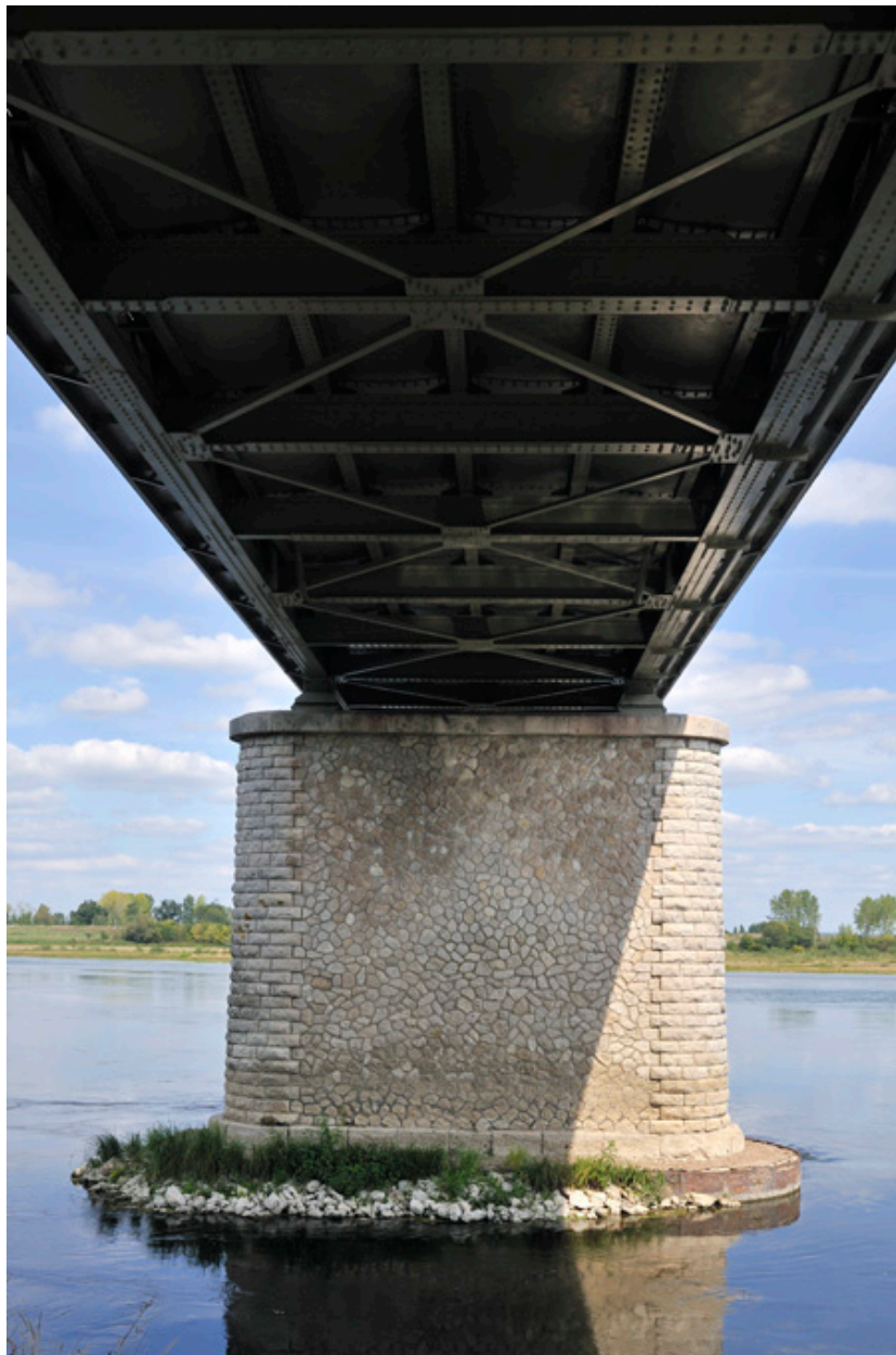
Radier, pile, longerons et sous-longerons du pont
