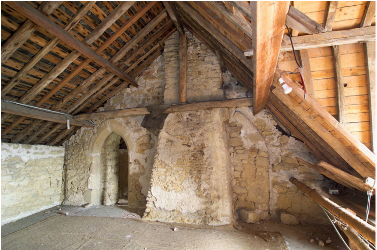
Mur de refend oriental dans le comble au-dessus de la grande pièce du logis.
