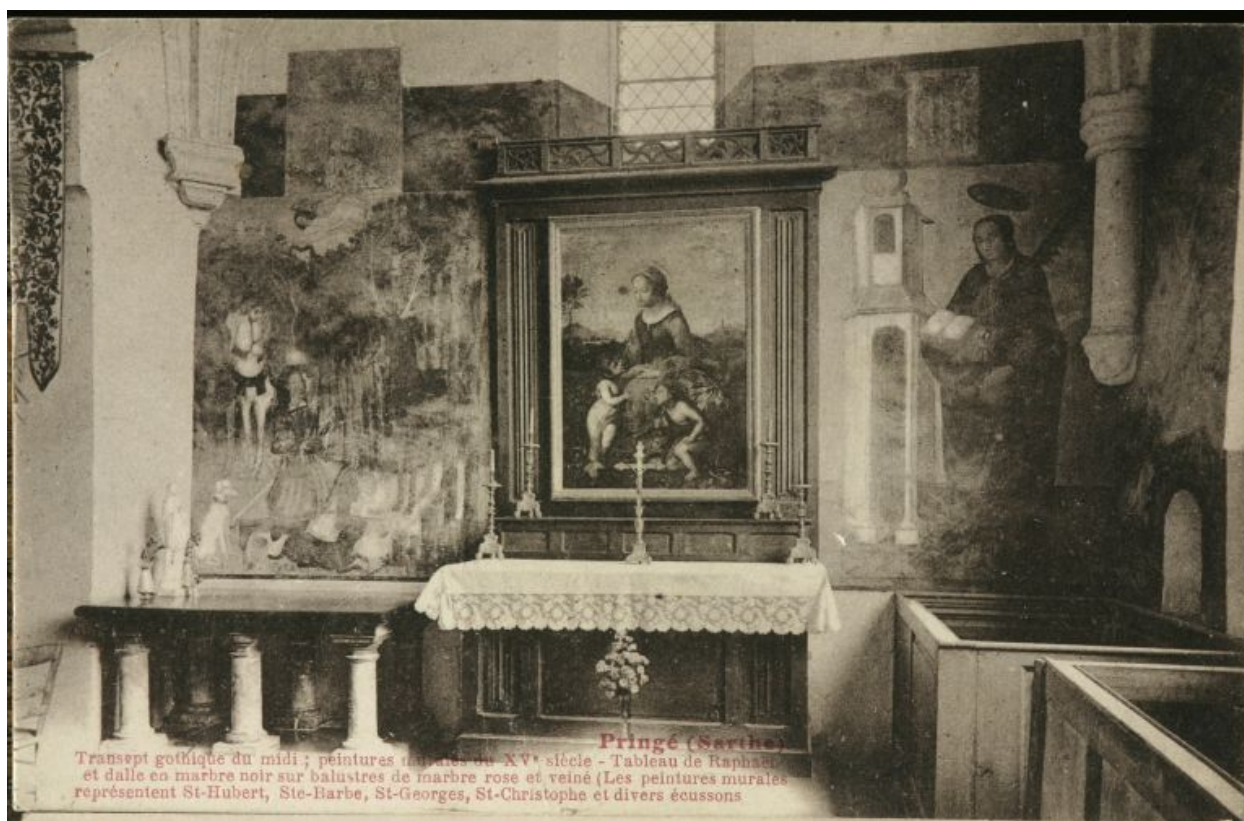
La chapelle seigneuriale avant travaux de restauration.
