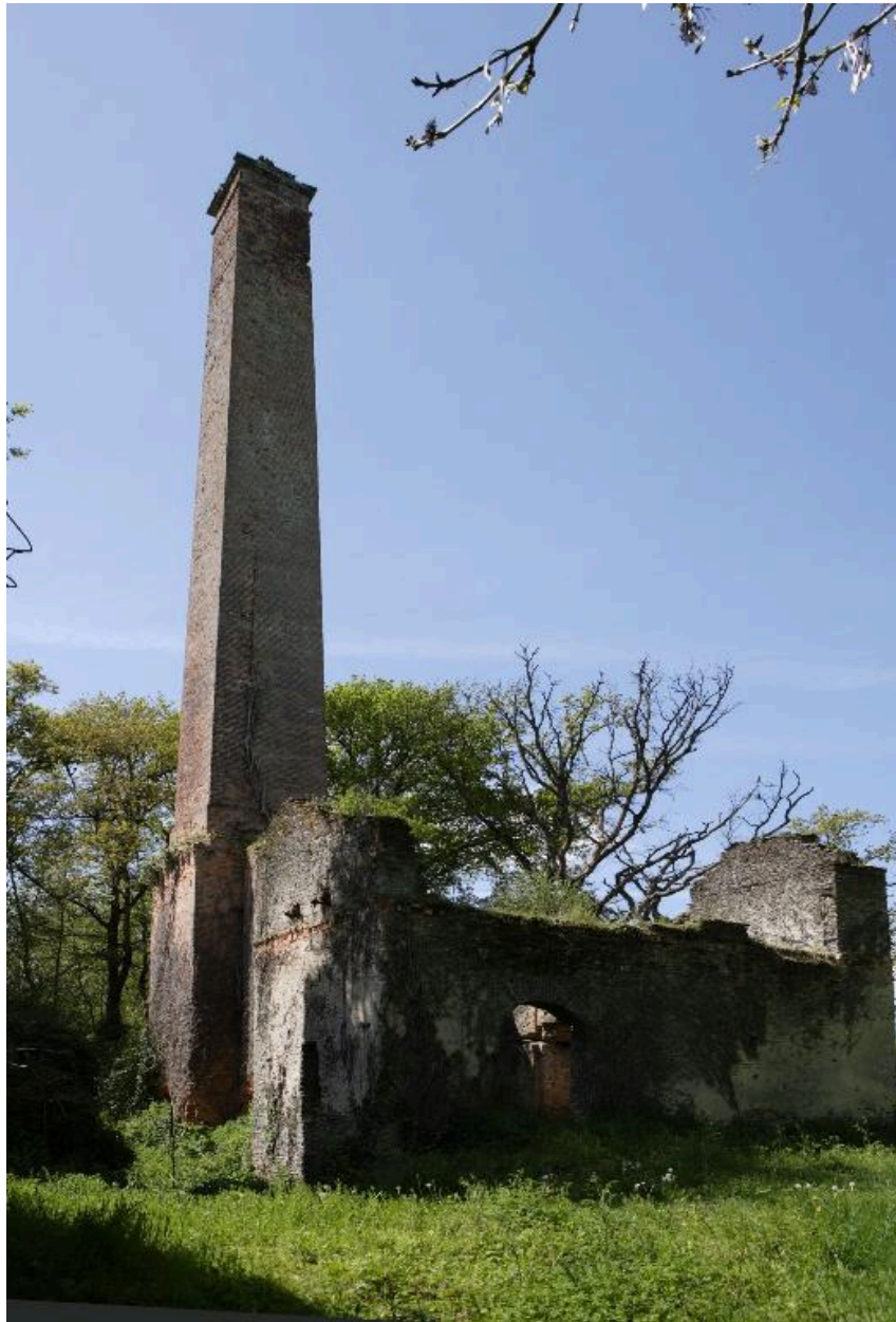
Bâtiment des machines à vapeur et cheminée de la chaudière.
