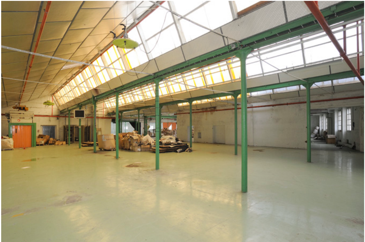
Atelier de l'usine Taïga (U1) situé dans la partie la plus ancienne du site.
