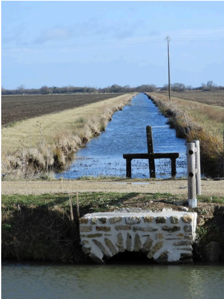
Arceau près de la cabane des Bardettes, à Sainte-Radégonde-des-Noyers, sur la rive gauche du canal du Clain, avec crémaillère en bois.
