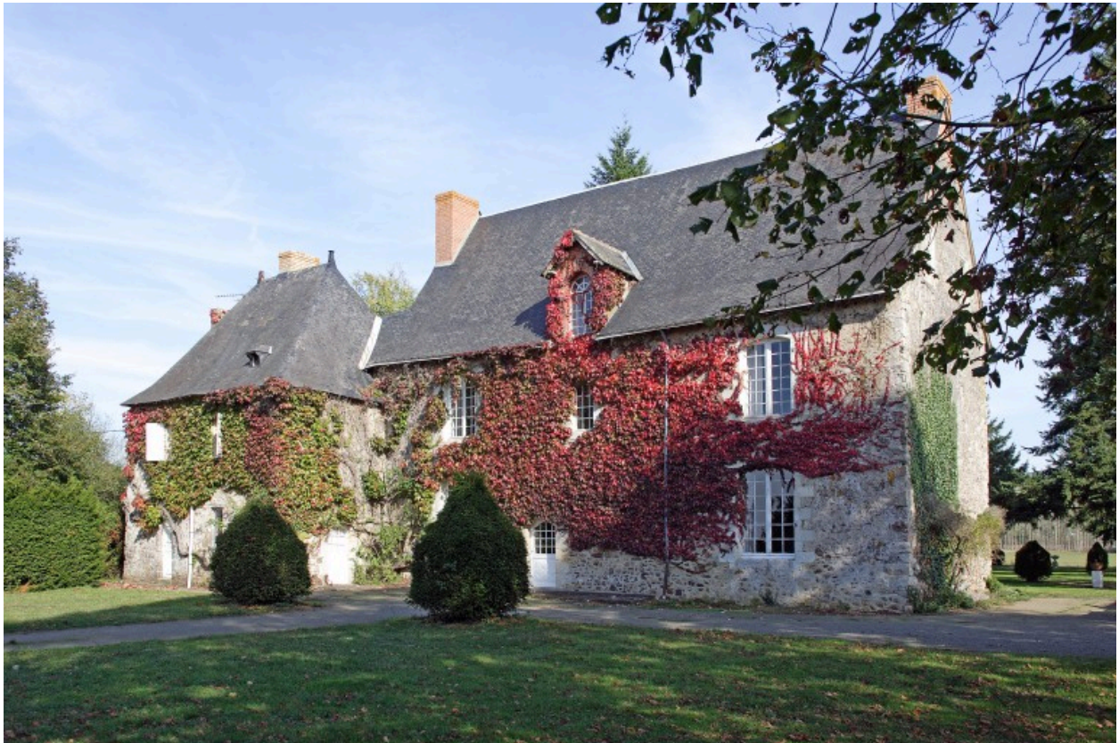
La façade antérieure vue depuis le sud-ouest.
