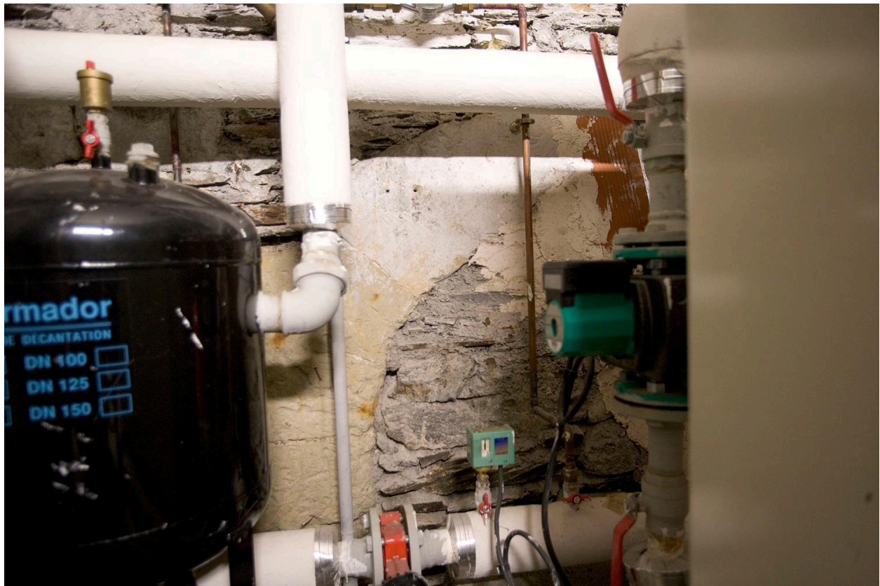
Corps de bâtiment du petit séminaire, sous-sol : cave 4, face latérale gauche, vestiges de porte romane.
