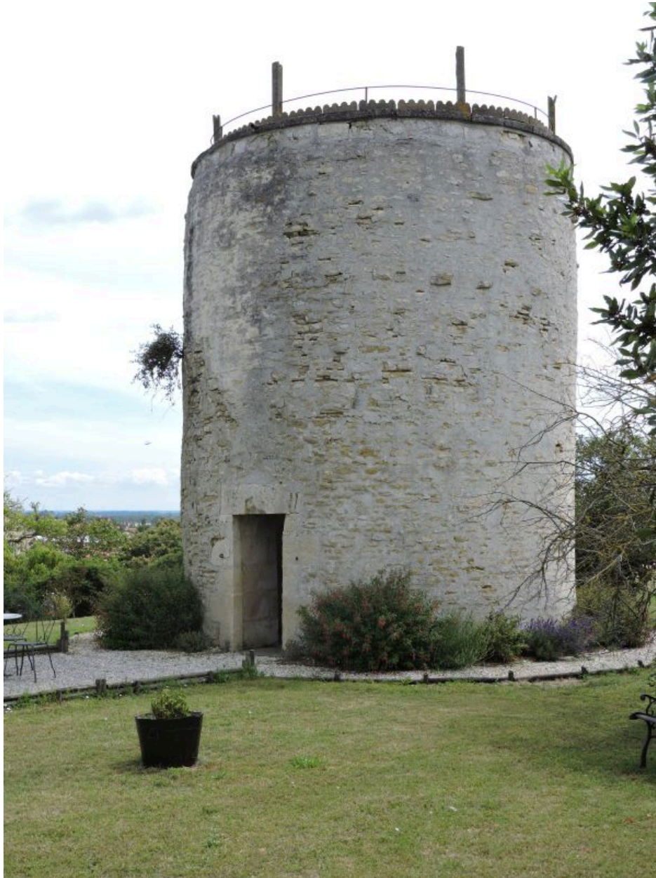
Le moulin vu depuis l'ouest.
