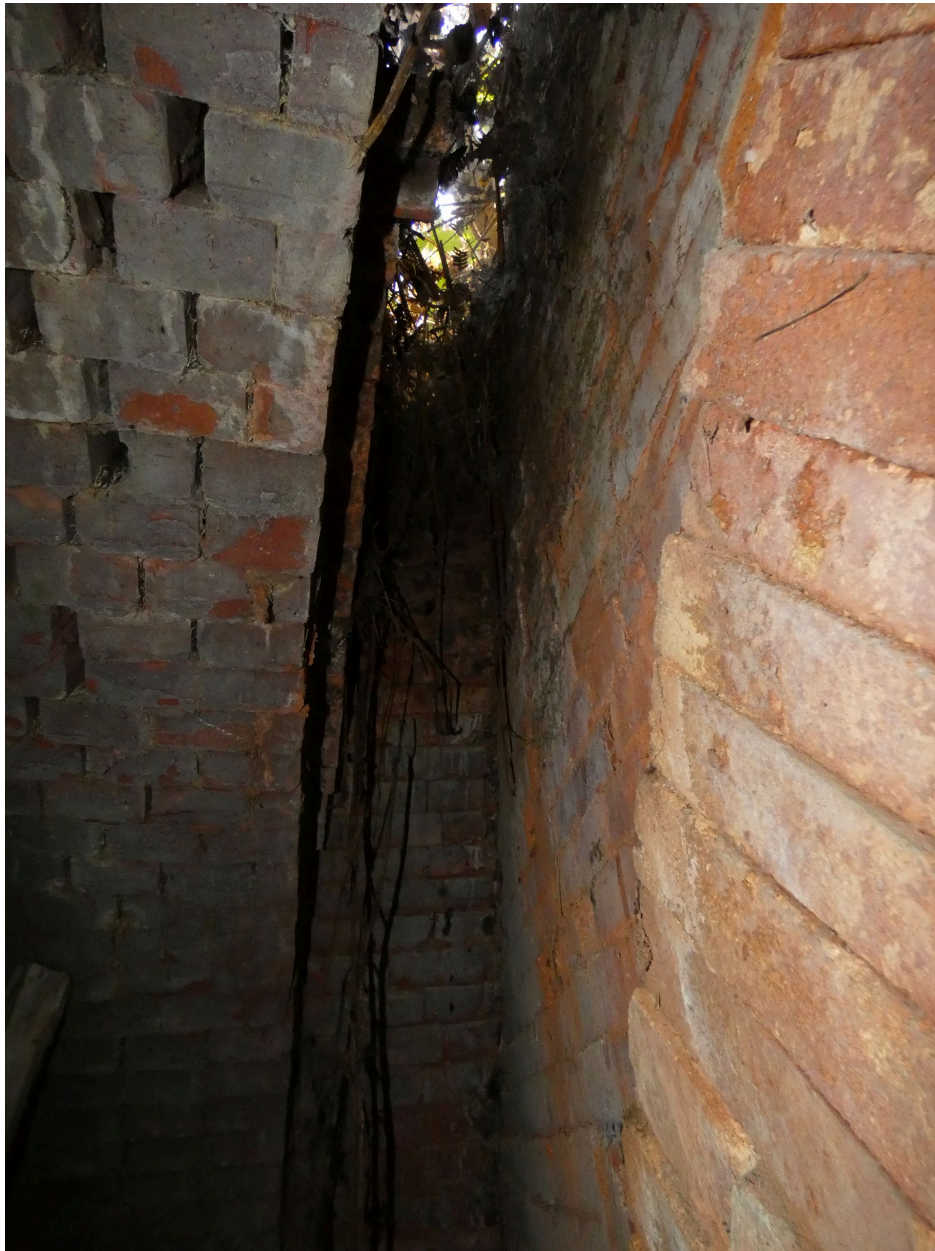
Le conduit d'évacuation au-dessus de la porte d'enfournement du second four.
