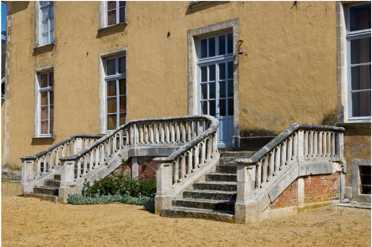
Escalier d'accès au corps central du logis.
