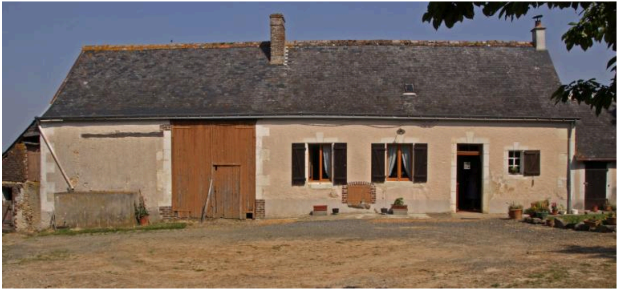
Maison 2 : façade antérieure sur cour.
