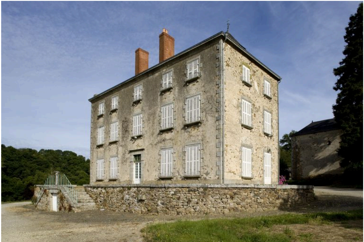
Le château : façade principale vue de trois-quarts depuis le sud-est.
