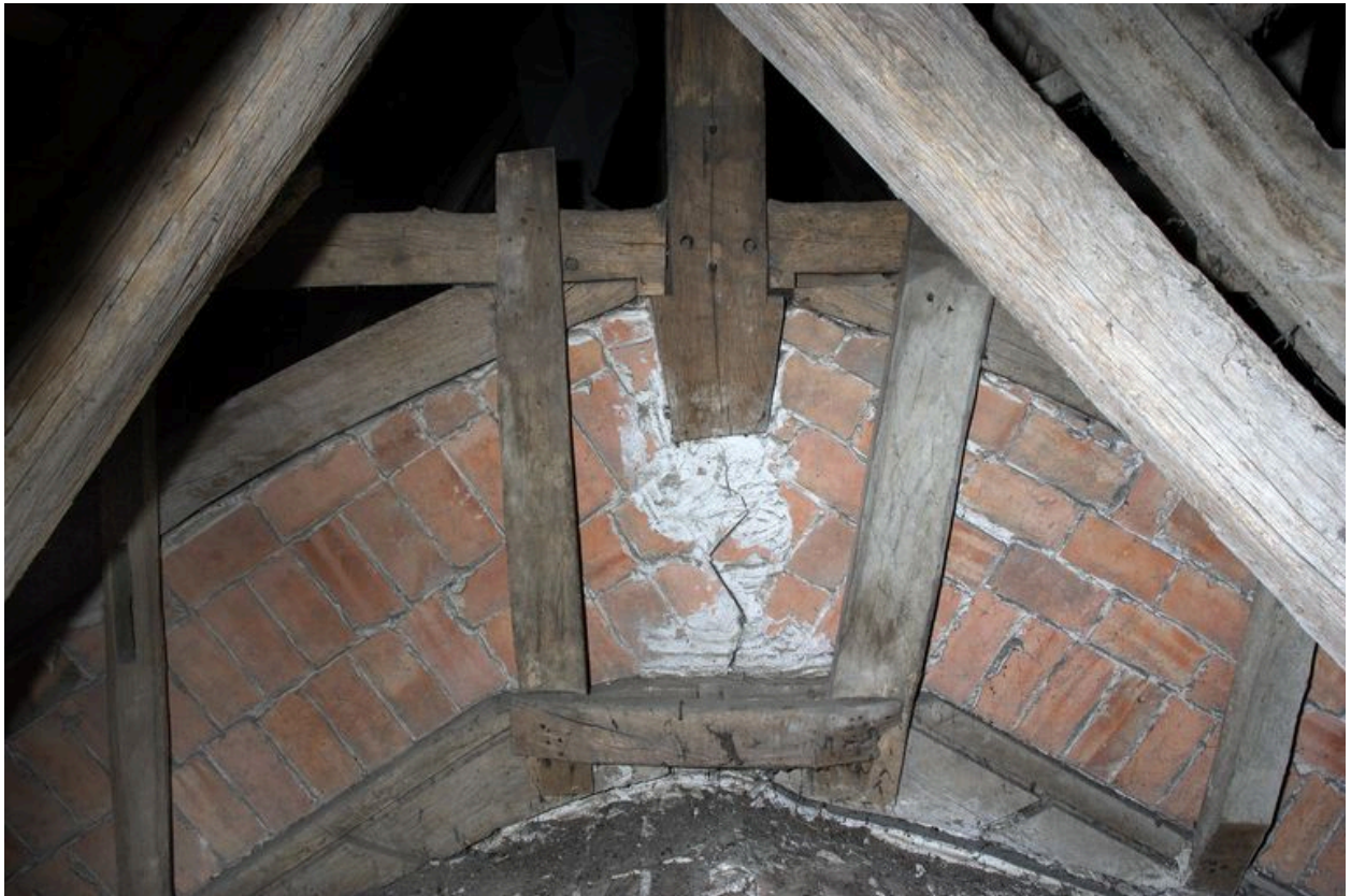
Charpente de la nef : vue partielle de la dernière ferme depuis la charpente du choeur.
