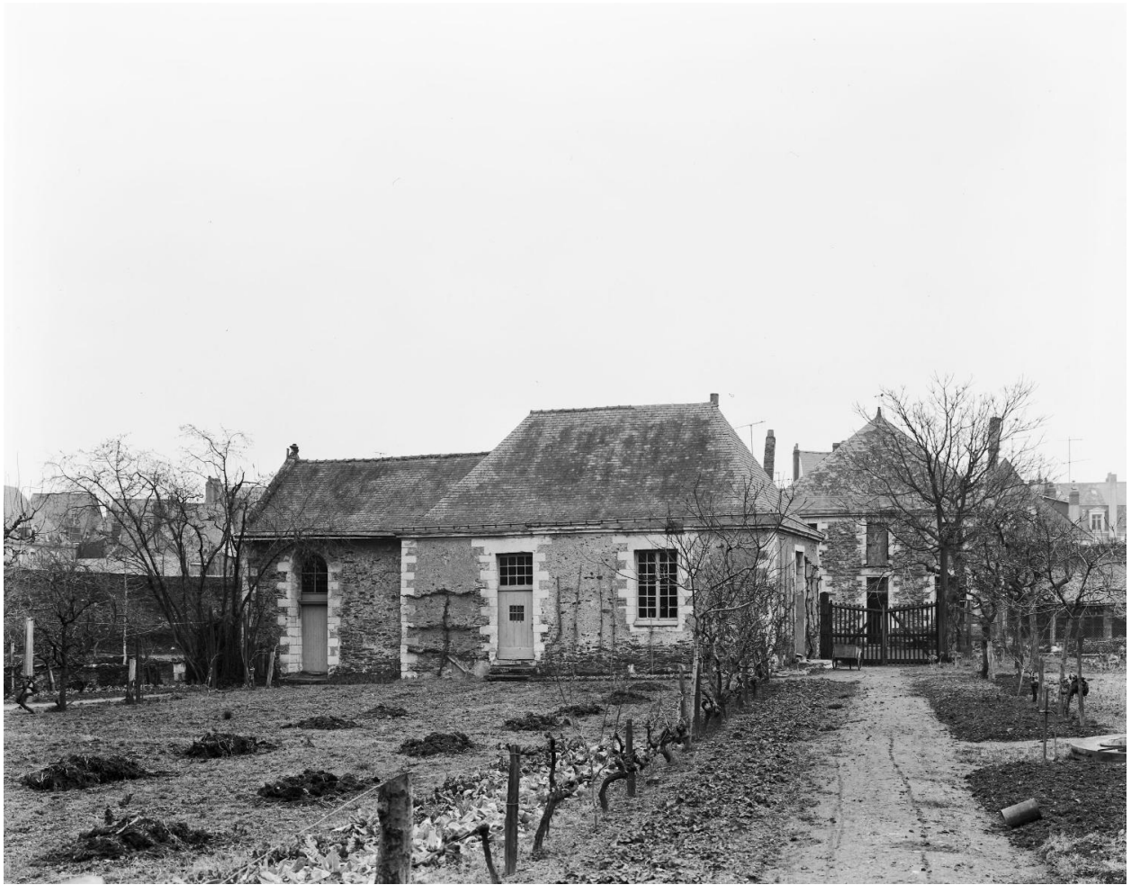
Chapelle et maison dite du Souvenir : façade ouest. A l'arrière-plan, bâtiment de la basse-cour.
