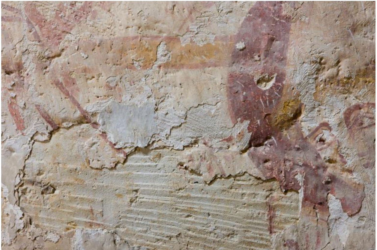
Ancienne chapelle, mur oriental, côté gauche, registre inférieur : vue en lumière rasante de la tête de saint Blaise.
